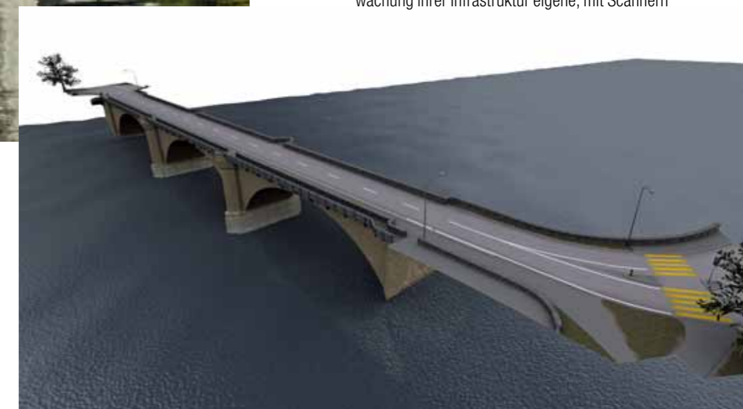
Die 3D-Visualisierung der Brücke zeigt die Oberfläche und die Geometrie mit digitaler Präzision.
