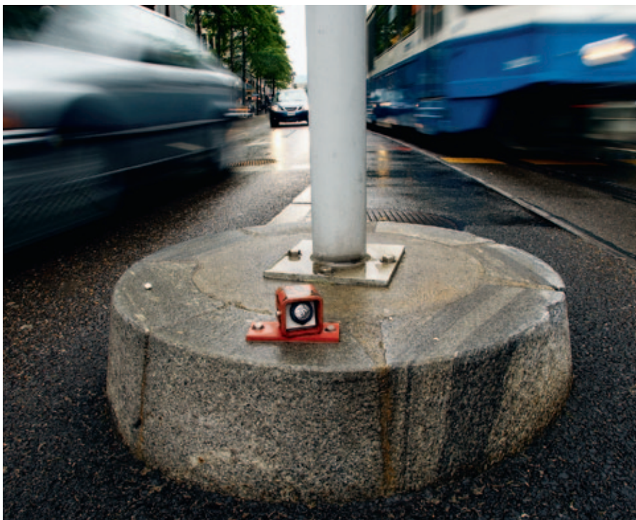
Auch vor dem Hauptbahnhof wurden Tachymeter installiert, um über kleine Reflektoren regelmässig Informationen über allfällige Abweichungen zu erhalten.
