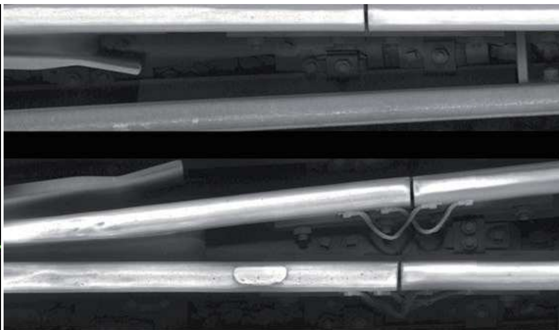
Der Schienenzustand wird auch fotografisch erfasst.
