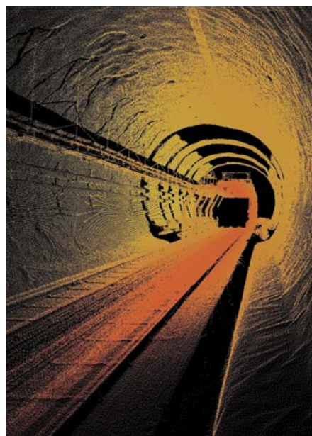
Abb. 2: 3D-Punktwolke der Spritzbetonoberfläche.
